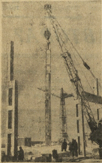
Одна за другой встают колонны на строительстве цеха сварных металлоконструкций.
