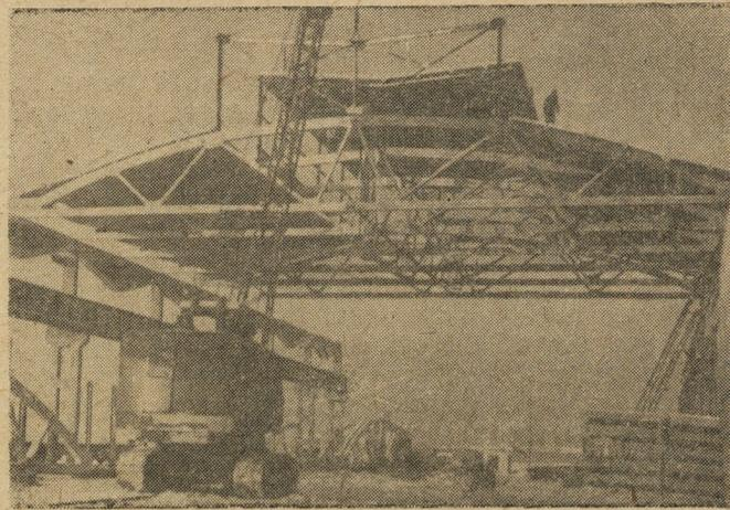
На строительстве цеха сварных машиностроительных конструкций будут применены многие прогрессивные методы и материалы. В частности, предполагается использовать значительное количество сборных железобетонных изделий. Уже сейчас над пролетами строящегося цеха-гиганта устанавливаются 30-метровые фермы с напряженной арматурой.
