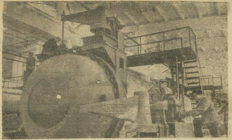
НА СНИМКЕ: монтажник треста «Союзшахтоспецмонтаж» Н. И. Волоснов, бензорезчик В. А. Зайцев и монтажник В. Головкин собирают затвор автоклава на строящемся заводе ячеистых бетонов.
