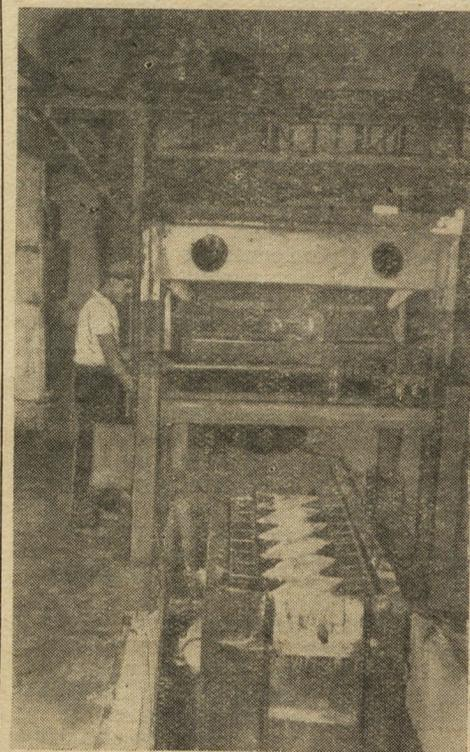
Хорошо оборудован формовочный цех Шарташского домостроительного завода. Здесь налажено производство карнизных и балконных плит, лестничных маршей, перемычек и других железобетонных изделий.
