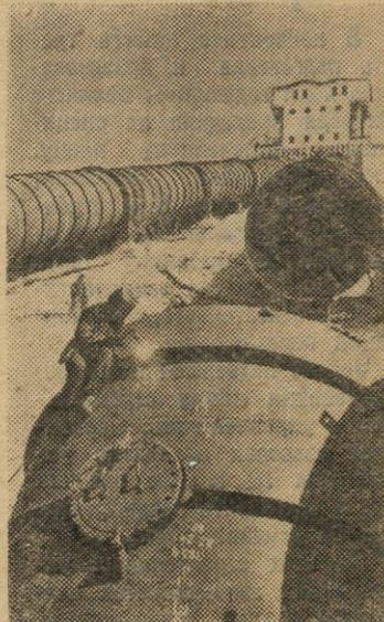
Строительство в Армении Атарбекянской ГЭС, входящей в Севано-Разданский каскад, вступило в предпусковой период. Выполнен огромный объем работ. Установлены турбины, генераторы, сооружен подводящий канал. Заканчивается монтаж напорного трубопровода и открытой подстанции.
