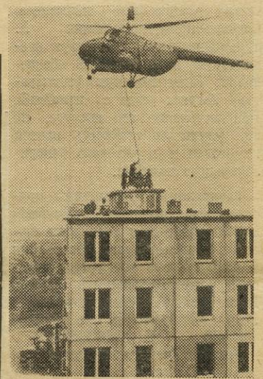
Жилой дом, построенный с крыши методом последовательного подъема смонтированных на земле этажей. Недавно с помощью вертолета гидродъемники были сняты с десяти железобетонных колонн.
