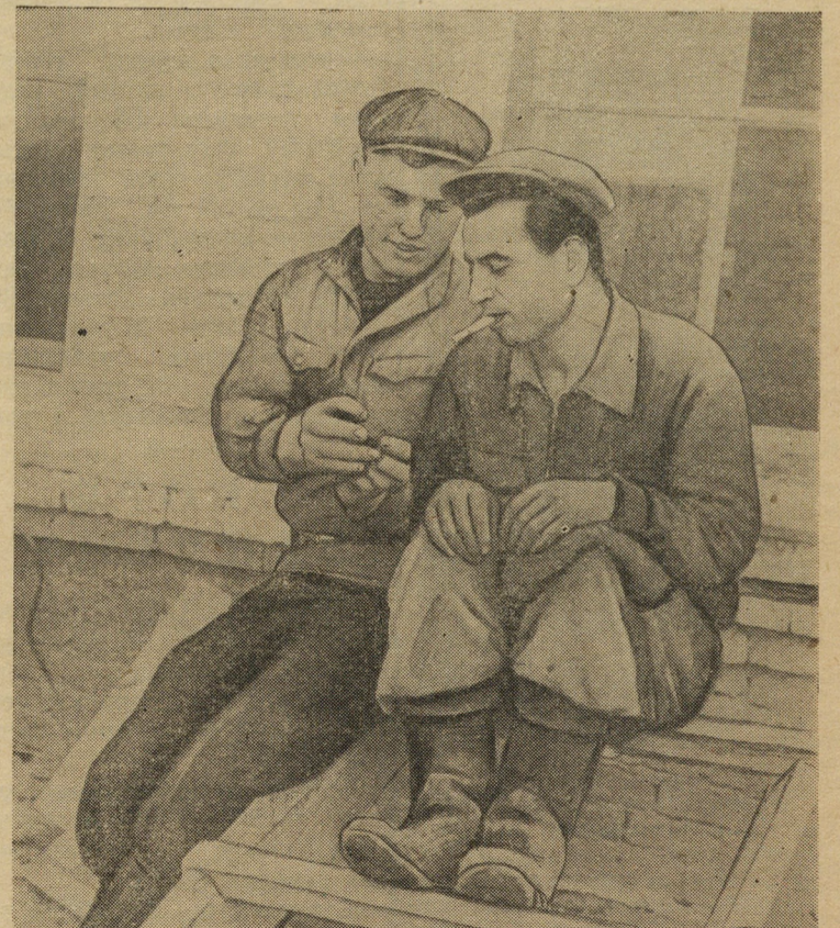
Ханкиши Суркулаев приехал в Свердловск из Баку, а Иван Макеев из-под Кургана. Здесь, на стройке, они подружились: Оба работают бетонщиками в 754 управлении. Трудятся друзья быстро и умело.
