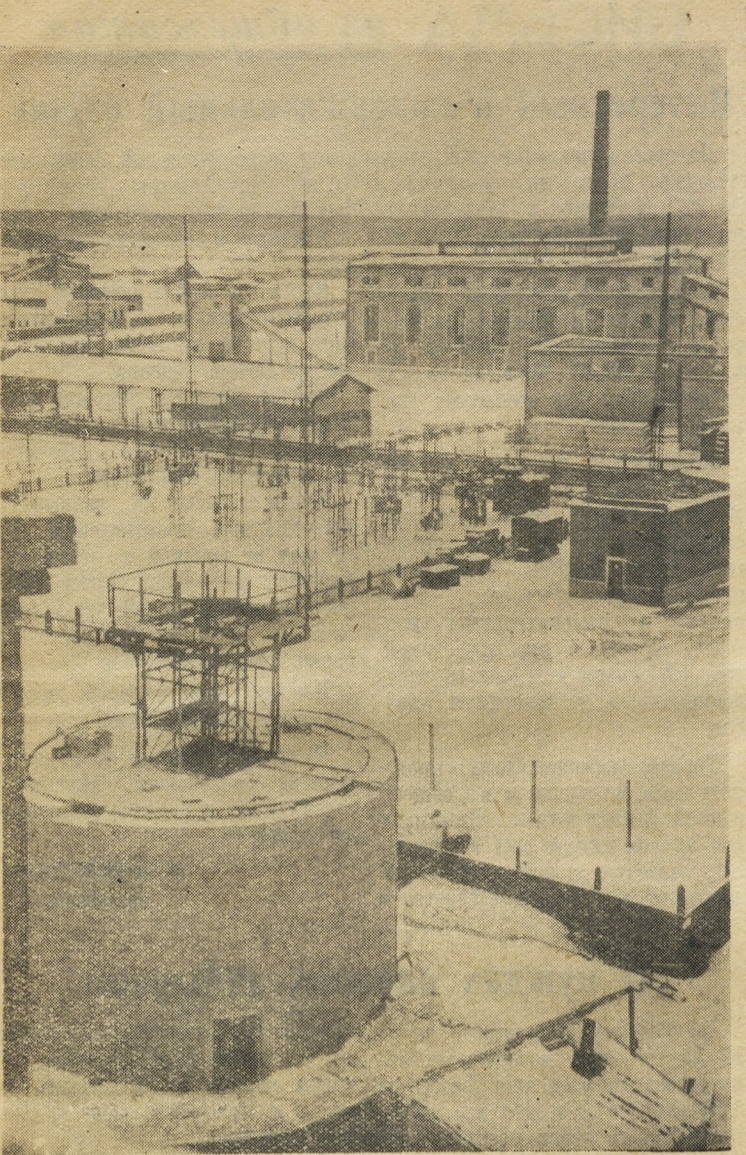
Вступают в строй первые объекты камвольного комбината: трансформаторная подстанция и котельная. Хорошо поработали на сооружениях этих объектов электрики с участка прораба тов. Емельянова (трест «Уралэлектромонтаж»), плотники из бригады тов. Ценева и многие другие.
