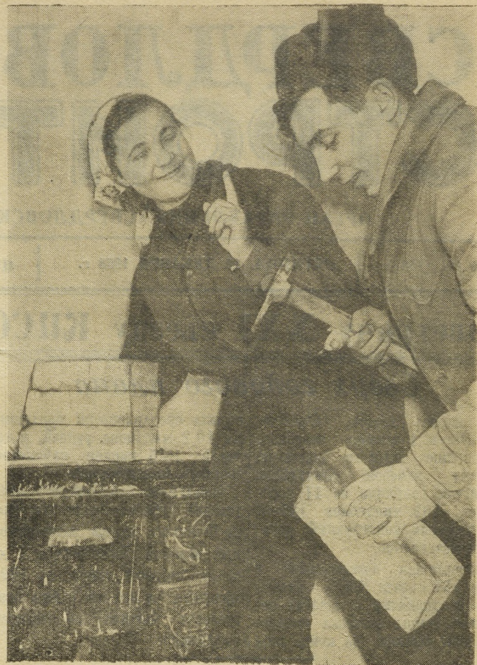
— Опять от целого откалываешь! А ты поищи половинку. Г. Кузнецова и В. Сафроненко, каменщицы из хозрасчетной бригады тов. Шорина (УНР № 232) быстро и качественно устанавливают кухонные плиты в 128-квартирном доме.
