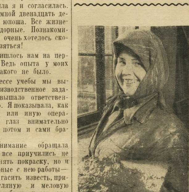
Комсомолка Тамара Речкалова работает штукатуром в бригаде тов. Ковалева на строительстве камвольного комбината и выполняет нормы выработки на 160 процентов. Фото А. Мусина.
