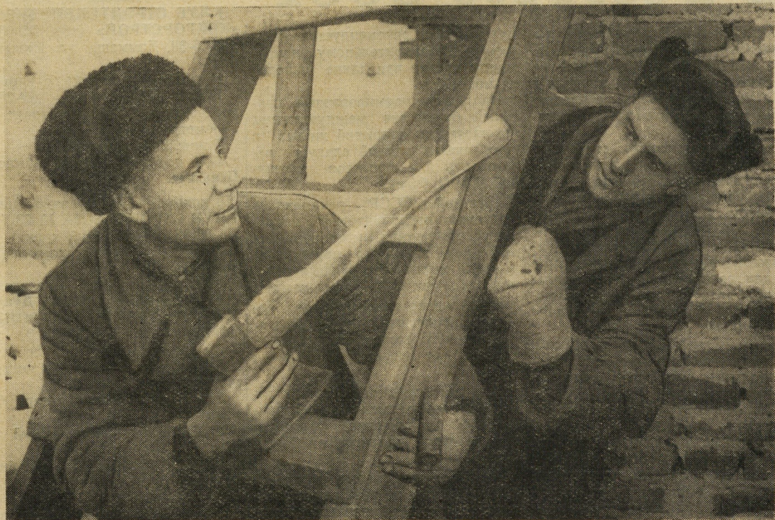
В четвертом строительном управлении треста «Южгорстрой» хорошо работает бригада плотников Бориса Соколова.
