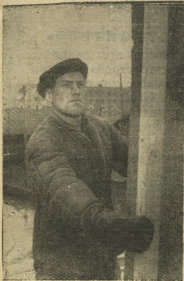
Бригада Василия Александровича Орлова первой в тресте «Южгорстрой» перешла на хозяйственный расчет. Ее примеру последовали другие, и теперь уже в тресте насчитывается несколько таких бригад.
