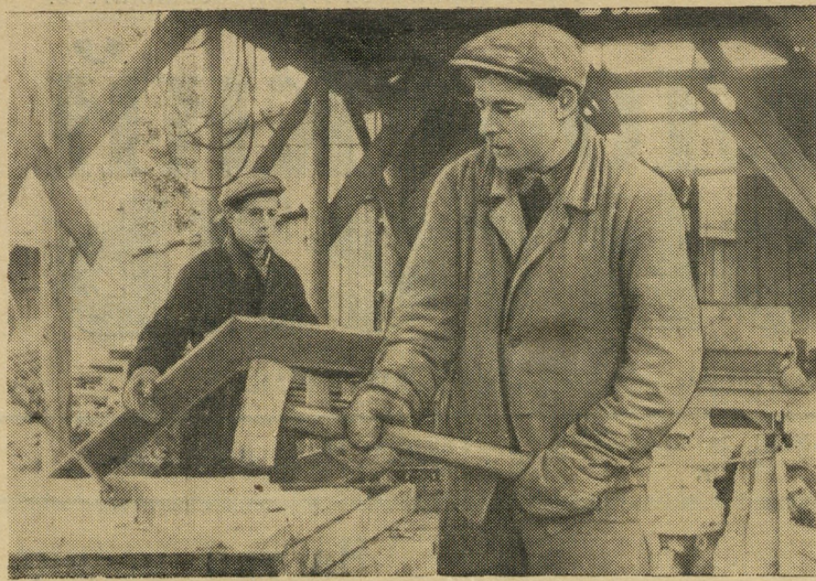
Бетонщики цеха № 2 завода железобетонных изделий Виктор Урих и Борис Сафонов добиваются не только высокой производительности труда, но и высокого качества железобетонных изделий. На снимке: В. Урих (справа) и Б. Сафонов раскрывают опалубку готового изделия.
