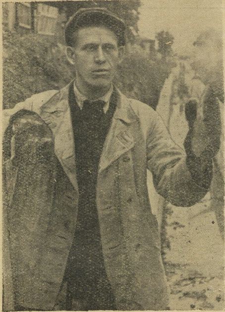
Хорошо трудится на строительстве левобережного коллехтора бригада монтажников А. В. Павлова.
