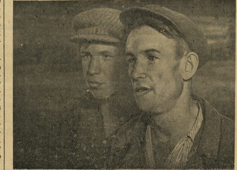
С начала строительства школы на улице Мира здесь работают братья Николай и Анатолий Бобылкины. Это хорошие такелажники и хорошие плотники. Да и от другой работы они не отказываются. Стройку они любят и не представляют себе, как можно работать где-то в другом месте. Это не удивительно. Ведь вся их семья — строители. 24 года проработал на стройках их отец — плотник Бобыкин. Недавно пришел на строительство младший брат Анатолий, окончивший десятилетку.
