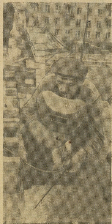
Комплексная бригада В. Шилака выполняет все работы по возведению стен дома, которые облицовываются силикатным кирпичом; установке перегородок, штукатурке стен, укладке панелей и балконных плит.
