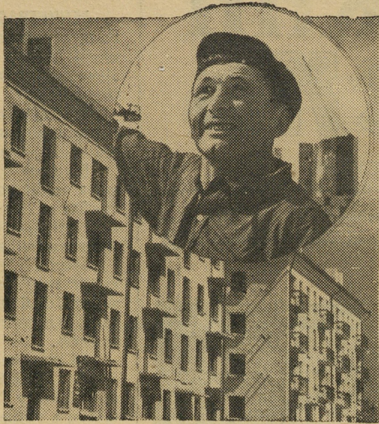
НА СНИМКЕ: бригадир В. Т. Цейгер и дома, смонтированные его бригадой. В. ЦЕЙГЕР, бригадир монтажников треста «Базстрой». Снимок И. ИСАКОВА.
