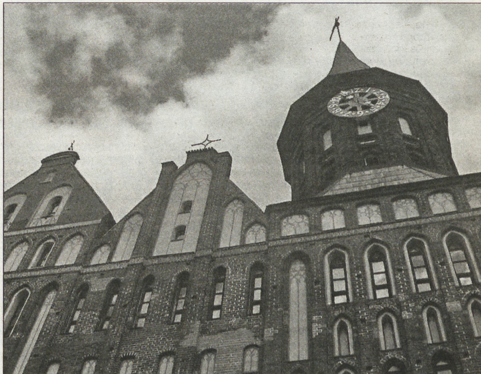
В Калининграде всегда найдутся здания, нуждающиеся в реконструкции.
