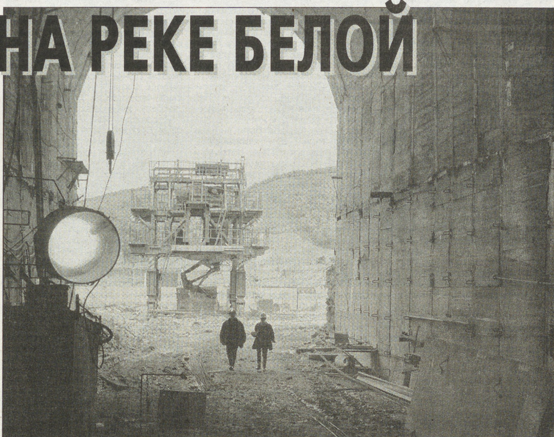
По этому туннелю пройдет часть нового русла реки Белой.
