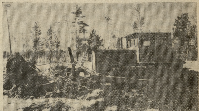
На снимке: тракторист П. С. Голендухин и его помощник В. В. Пономарёв производят раскорчёвку леса на тракторе С-80 специальной машиной на малопродуктивном сенокосе колхоза «Верный путь». Снимок М. Просвирнина.
