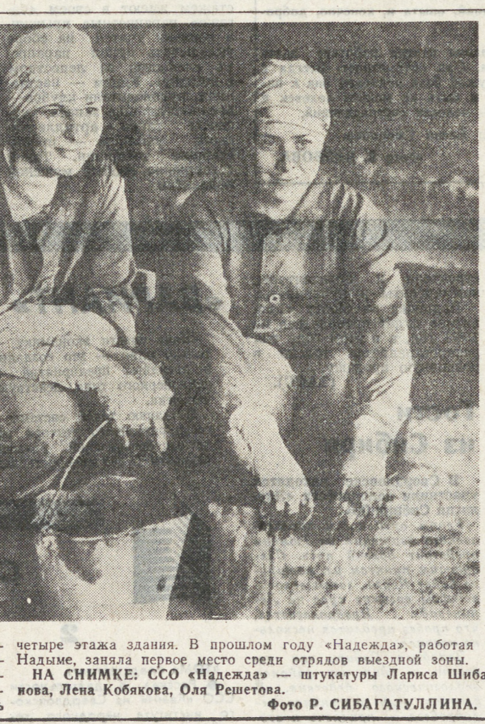
ССО «Надежда» из УПИ работает в поселке нефтяников Губкинского на Тюменском Севере. Более двадцати девушек с факультета технологии сыпучих материалов занимаются штукатурными работами в административно-бытовом корпусе объединения «Пурнефтегаз». За два месяца девушкам предстоит отштукатурить
