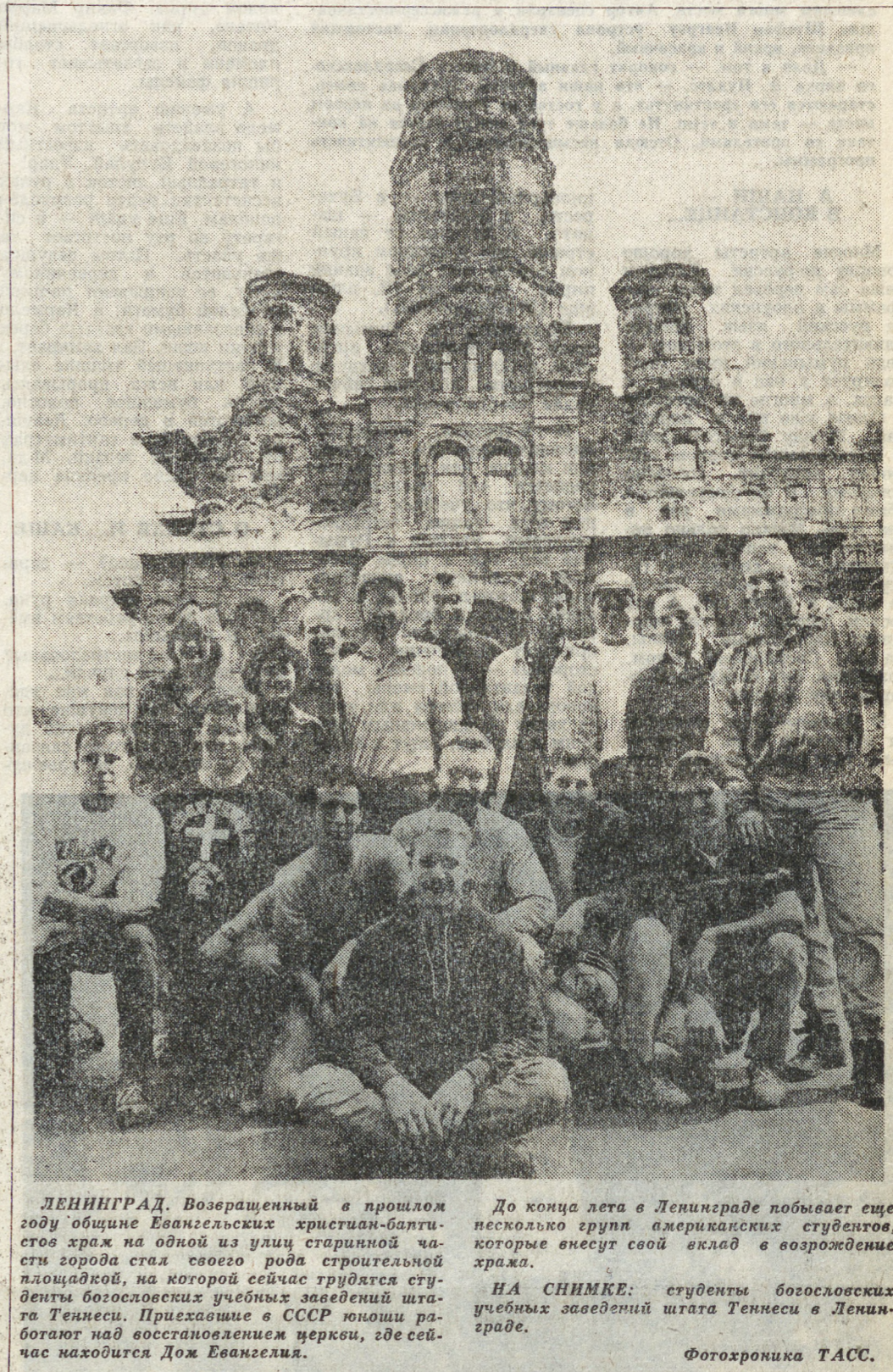
ЛЕНИНГРАД. Возвращенный в прошлом году общине Евангельских христиан-баптистов храм на одной из улиц старинной части города стал своего рода строительной площадкой, на которой сейчас трудятся студенты богословских учебных заведений штата Теннесси. Приехавшие в СССР юноши работают над восстановлением церкви, где сейчас находится Дом Евангелия.
