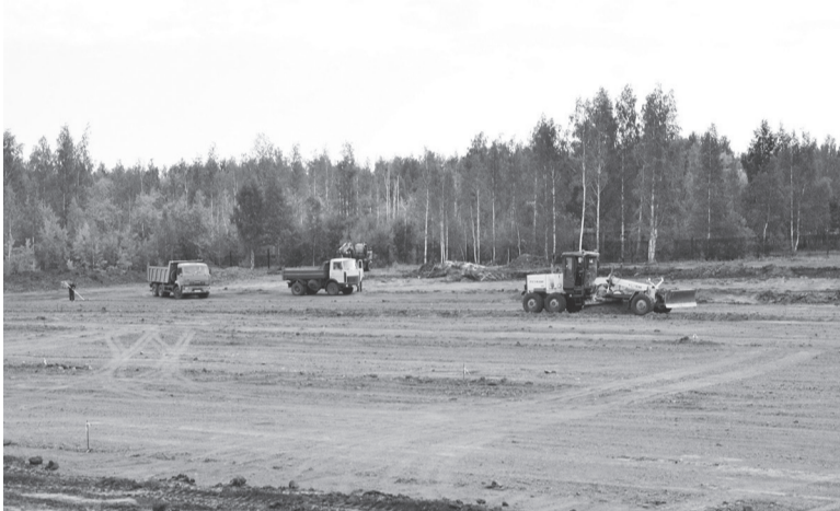
Начало строительных работ. Август 2023 года
