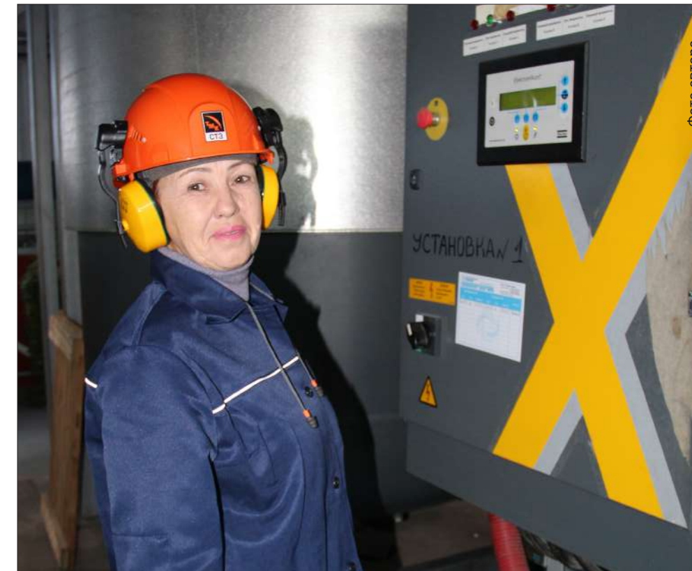
17 000 м³ сжатого воздуха в час осушает одна установка-осушитель. В течение смены Надежда Кобякова постоянно делает обходы машинных залов, чтобы проконтролировать работу оборудования
