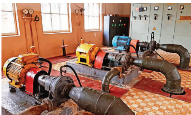
Без электричества оборудование НФС останавливается.
