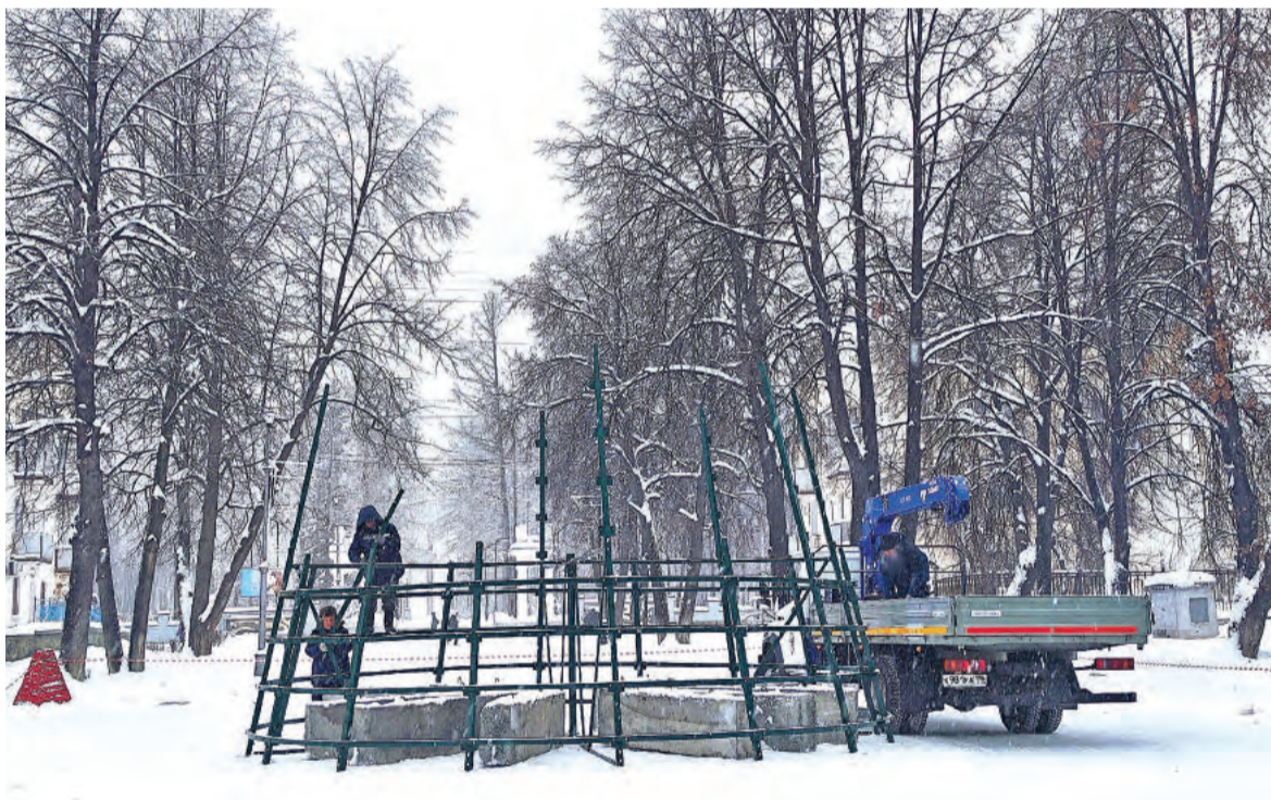
Сотрудники МУП «Энергосети» начали установку главной городской ёлки 4 декабря.
