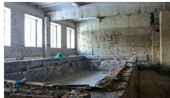
Ремонт бассейна поликлиники будет продолжен в 2024 году.
