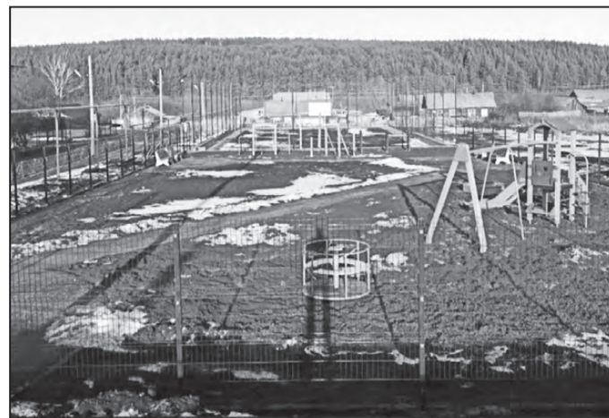
В рамках инициативного бюджетирования заканчивается строительство площадки в с. Старые Арти
