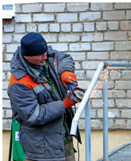
Обустройство перил у подъездов домов.
