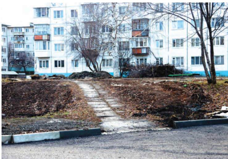
Обустройство новых тротуаров запланировано на 2024 год.
