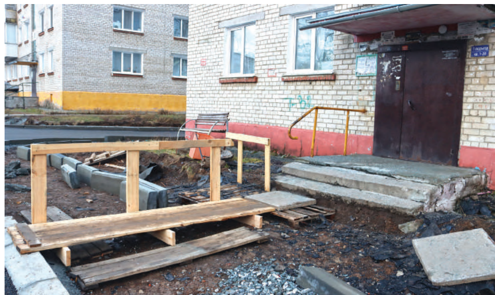
Временные настилы к подъездам Кирова, 32.
