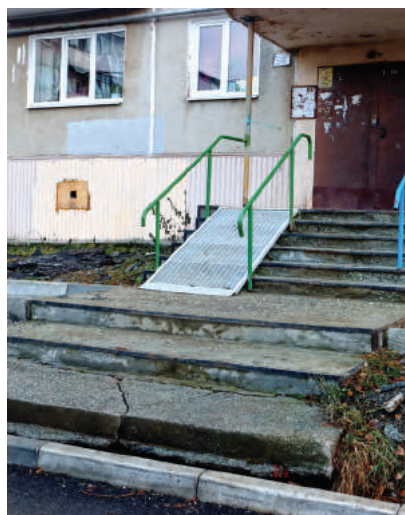
Ремонт крылец обязательно состоится.
