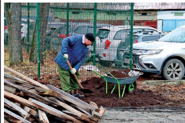
Засыпка газонов плодородным грунтом.
