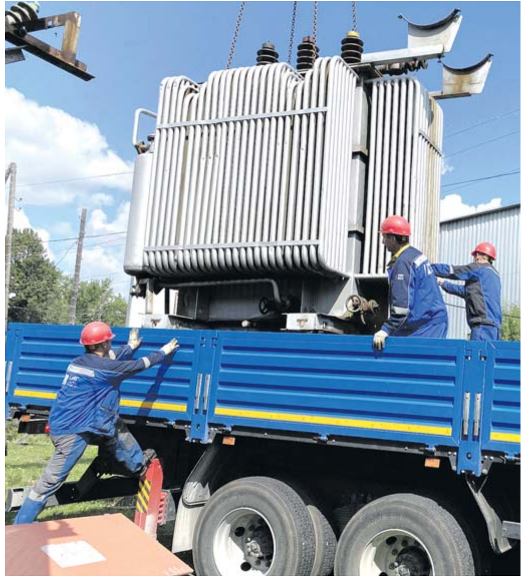
Демонтаж повреждённого трансформатора на подстанции «Нейво-Шайтанская» в июле этого года
