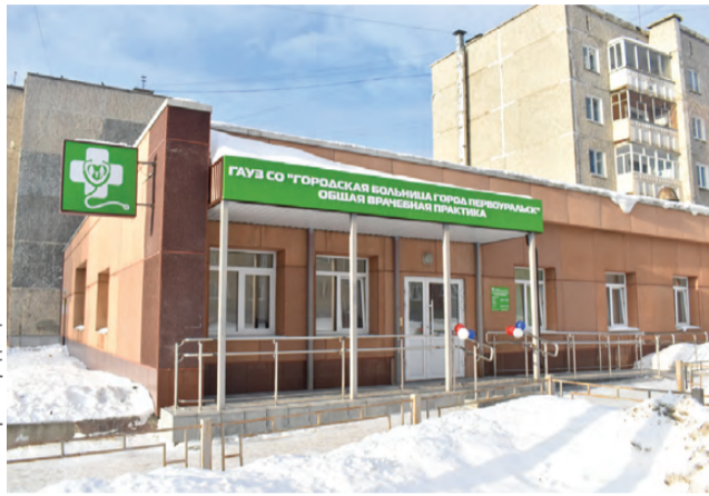
Капремонт ОВП стал прекрасным подарком для жителей Талицы
