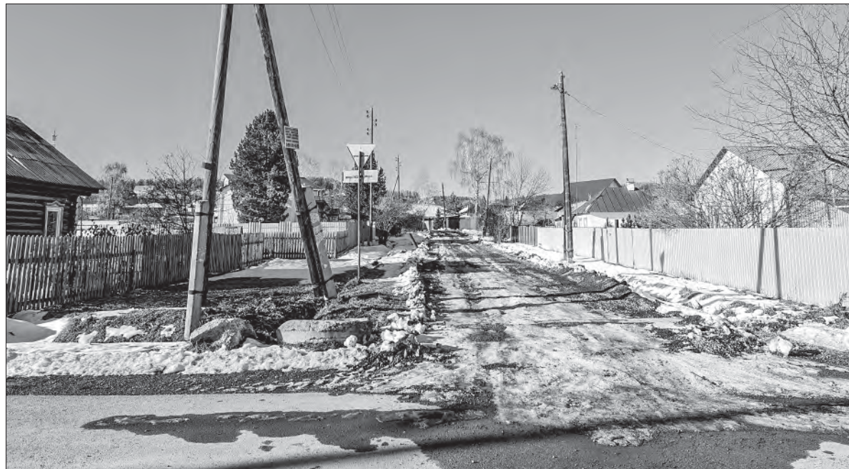
Улицу Павлова, на которой живёт Татьяна Сташкова, регулярно топит канализационными стоками
