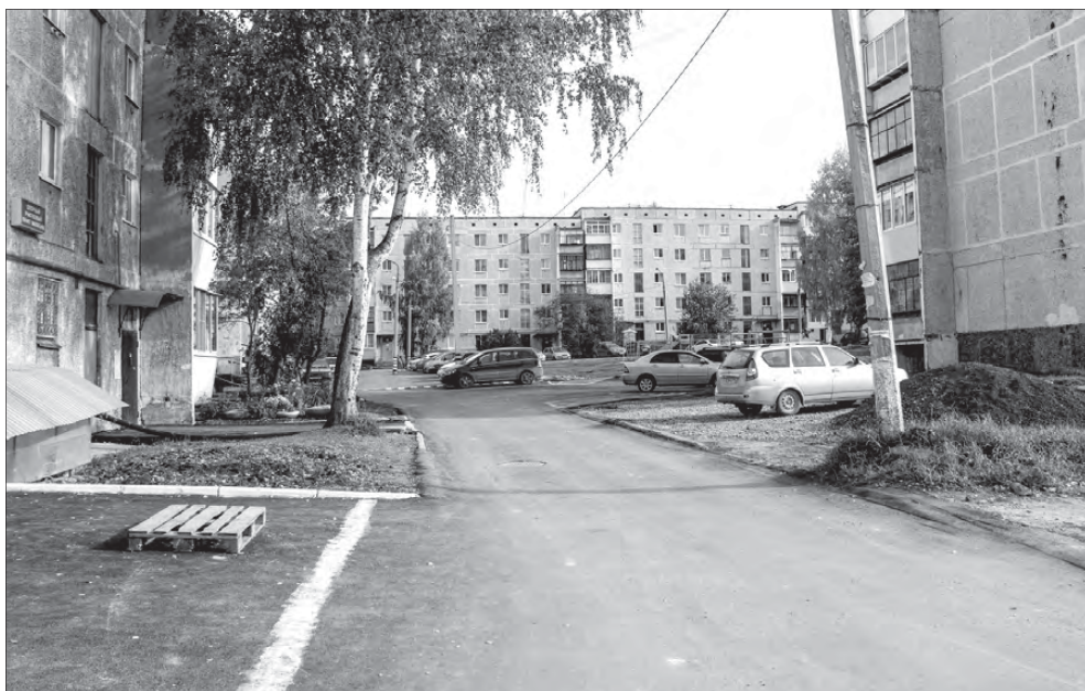
Во втором микрорайоне управляющей компанией «Южное коммунальное предприятие» благодаря помощи депутатов во дворе дома № 6 восстановлен асфальт проезжей части, расширена парковка, отремонтированы канализационные колодцы
