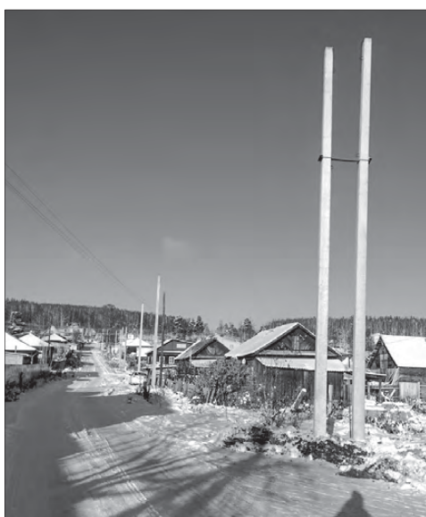
С прошлого года ведутся работы по замене опор и светильников уличного освещения в посёлке Зюзельский
