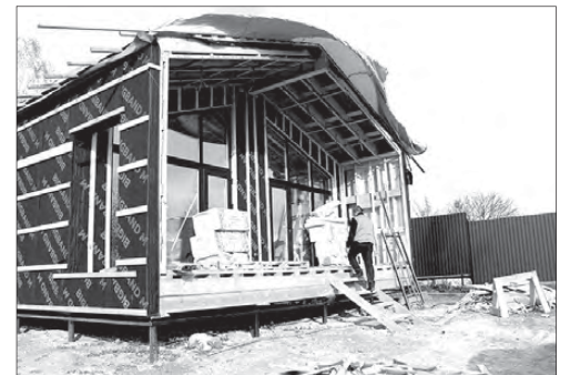
Устройство тёплого контура с гидроизоляционным наружным контуром
