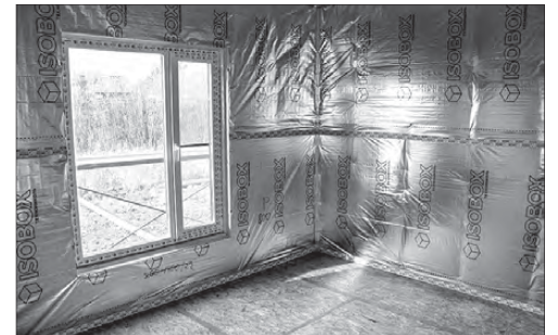
Изнутри стены покрываются пароизоляционной плёнкой с проклейкой скотчем и герметиком для предотвращения попадания влаги внутрь стены
