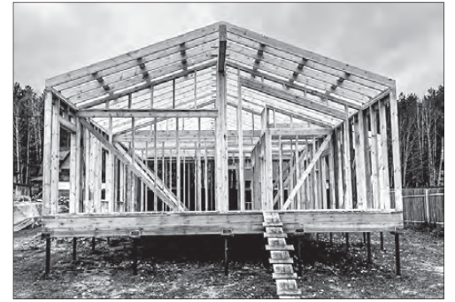
Возведение дома начинается со строительства фундамента и установки силового каркаса из сухого пиломатериала камерной сушки
