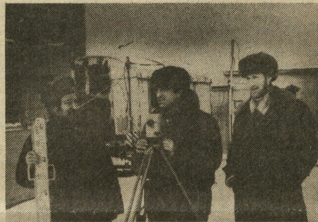
Геодезическая проработка будущих объектов — важное звено в нашем производстве. На снимке вы видите моменты именно этой работы, которую осуществляют прораб В. Красноробский и геодезисты М. Одегов и Ф. Ганиуленко (СФС) в квартале Ботанический.
