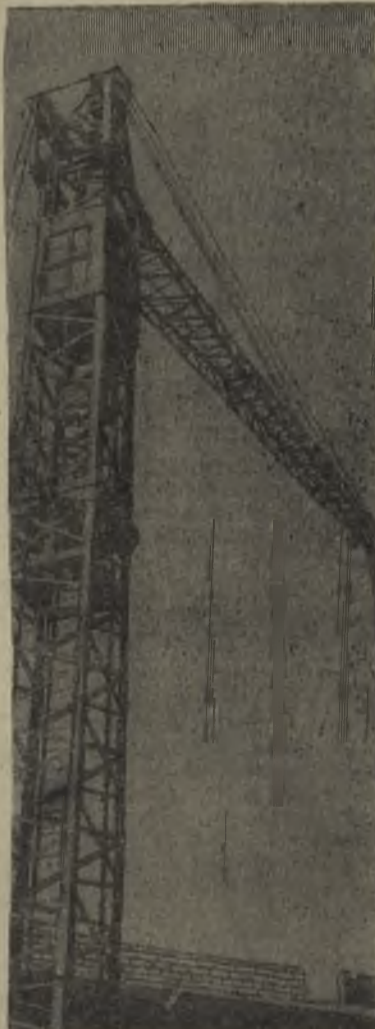
Башенный кран стал привычной деталью городского пейзажа. Этот сфотографирован на стройке 100-квартирного дома. Управляют им Вера Бойко и Галя Савина.
