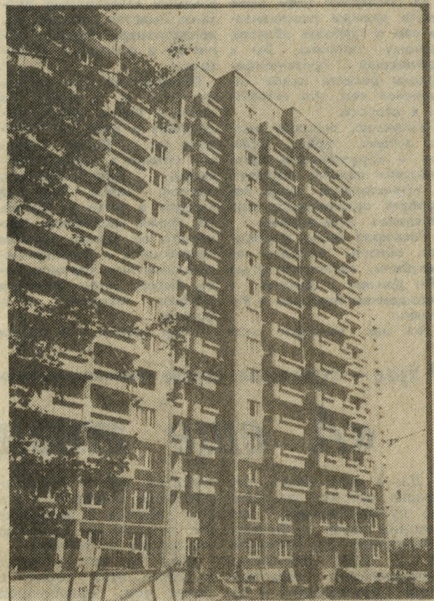
На снимке вы видите дом серии 137С под строительством № 30, в который в ближайшее время въедут трудящиеся дожостроительного комбината. Дом расположен в микрорайоне МЖК-4. Текст и фото В. Калижасова.
