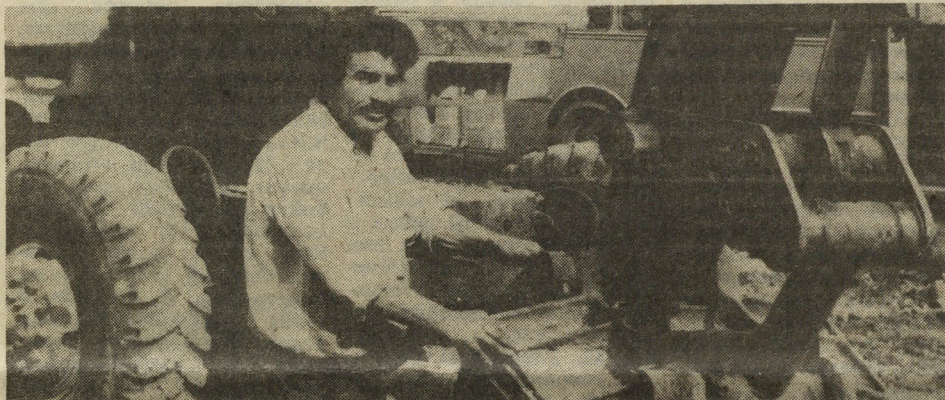
На улице Сыромолотова в микрорайоне «Комсомольский» строится группа высотных домов серии 137-С. На снимке: на доме № 11 трудится экскаваторщик СУ-29 А. Т. Первойкин.
