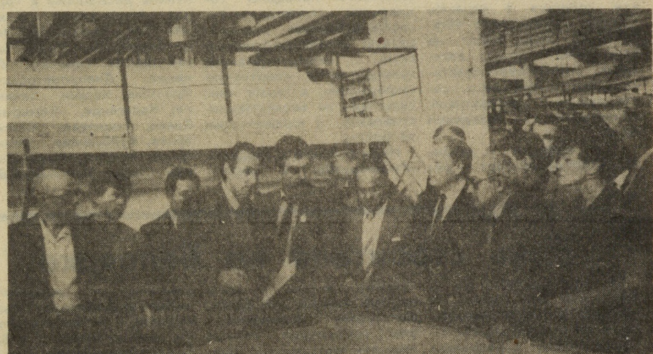
Заместитель начальника ДСК А. А. Волмский в цехе № 9 завода ЖБИ им. Ленинского комсомола дает пояснения участникам совещания строителей и архитекторов.
