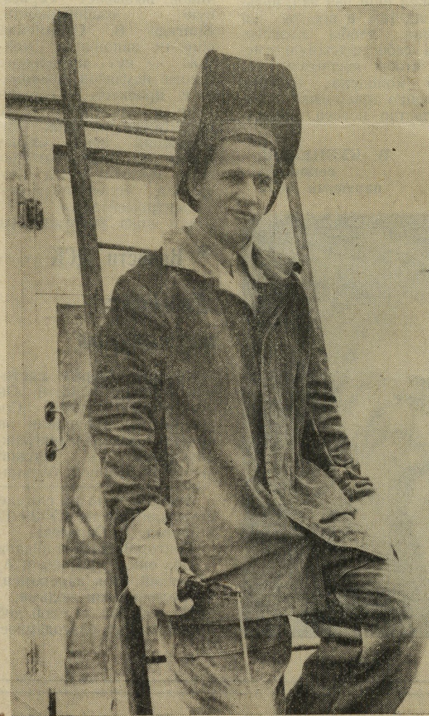
Заканчивается монтаж дома-эталопа в «Комсомольском», где трудится бригада монтажников Н. В. Муртакова из СУ-27. Предъявлять его государственной комиссии будет отделочное управление, но качество дома уже сегодня закладывают монтажники и, в частности, сварщик этой бригады Юрий Пьянков.
