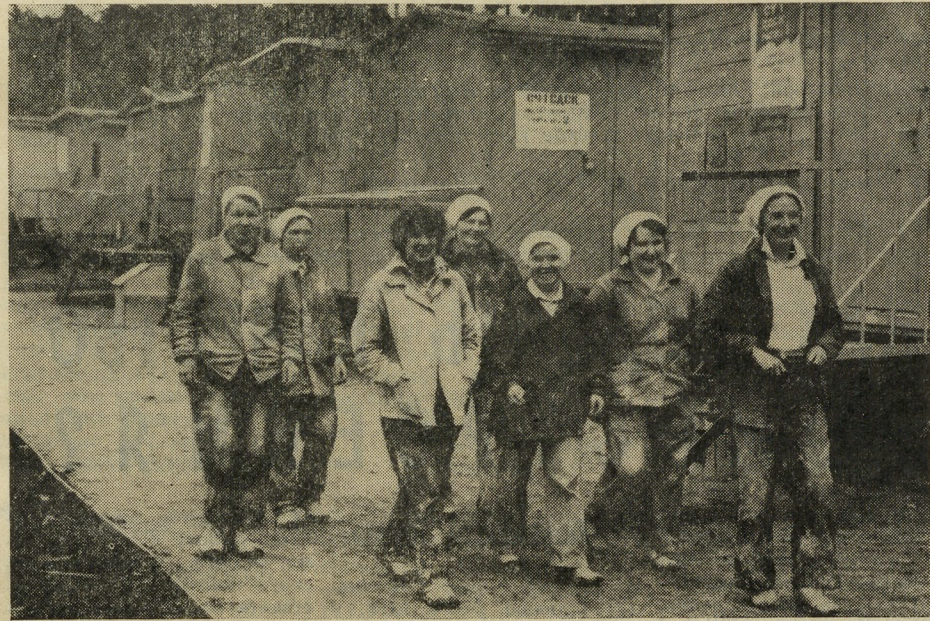
Успешно справилась с планом первого полугодия бригада штукатуров СУ-1 Валентины Александровны Ермошиной. Штукатуры достигли выработки 9,2 кв. метра на человека. Сегодня этот коллектив работает в счет октября 1984 года.
