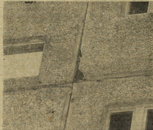
Видели этот брак монтажники, видели «проектористы» и даже народные контролеры. Но никто из них не реагировал на то, что плита устанавливается со сколом.
