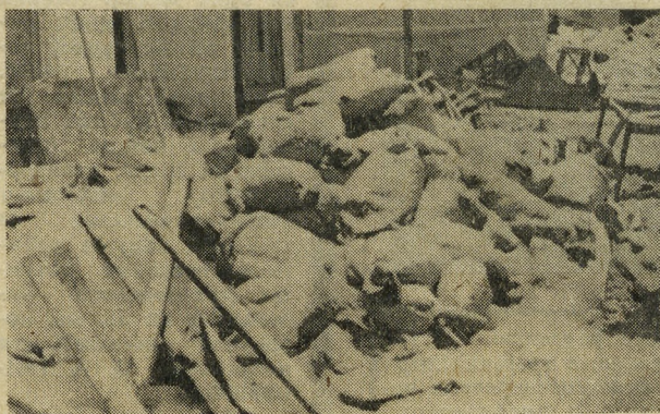
Нередко отделочники жалуются на нехватку стройматериалов, в том числе и цемента. Такой бесхозяйственности не поможет и сверхрасторпность снабженцев. Здесь, на доме № 22, работает коллектив строительного управления № 1.
