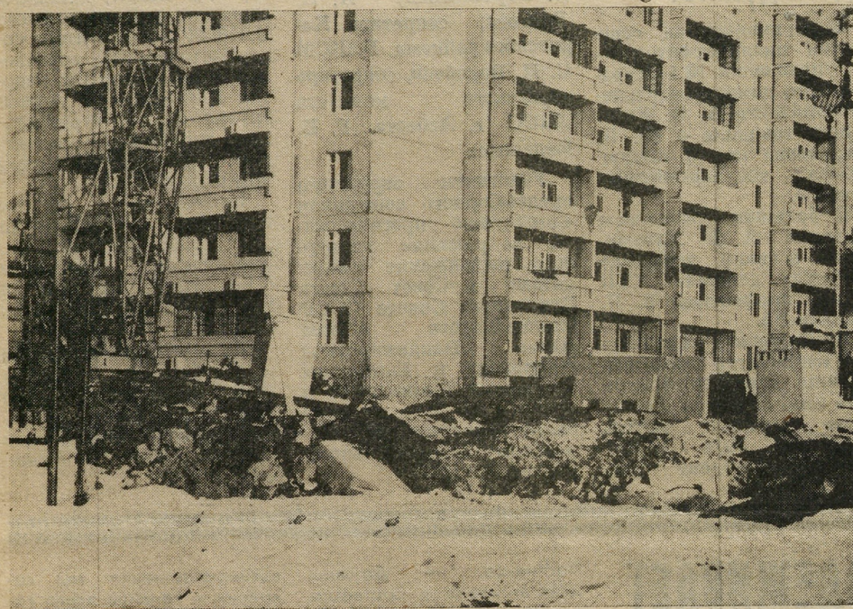
◆ Так выглядит строительная площадка дома № 56 (квартал «Академический») после сдачи дома государственной комиссии.
