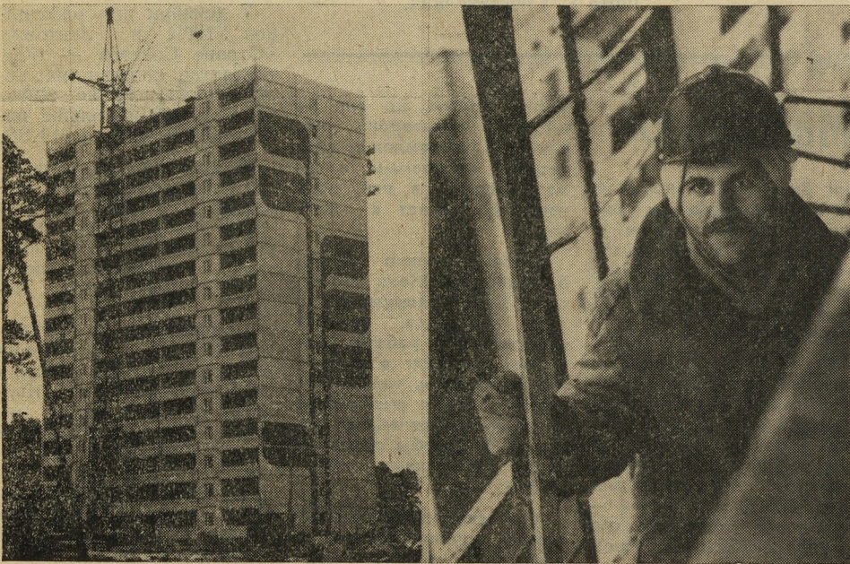
Завершается монтаж первого шестнадцатизэтажного дома в комплексе МЖК. Монтаж ведет бригада
