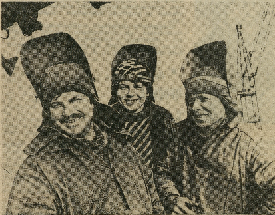
На месте бывшего болота поднимаются высотные дома нового жилого микрорайона «Комсомольский». На счету ударников коммунистического труда, электросварщиков Виктора Богданова, Рауля Гильмуллина и Ульфата Бикинина из СУ-27 десятки смонтированных домов.
