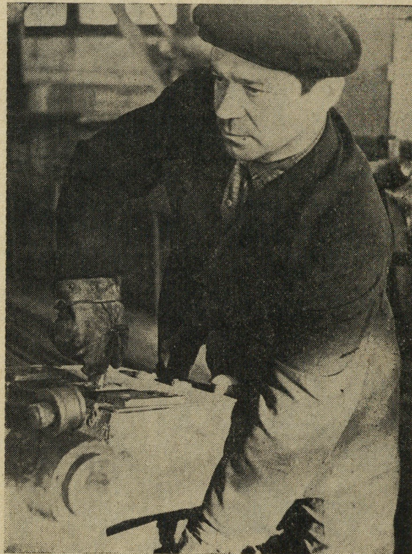
На снимке: бригадир арматурного участка П. С. ЧУЛКОВ. Фото В. Калимасова.
