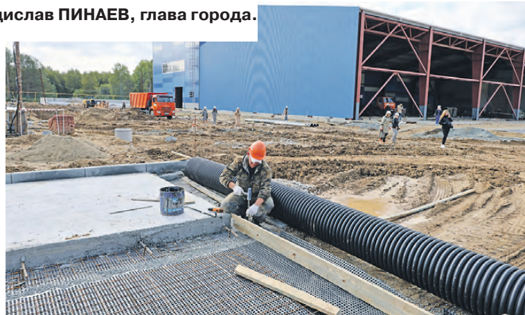
Работы по прокладке внутренних сетей.
