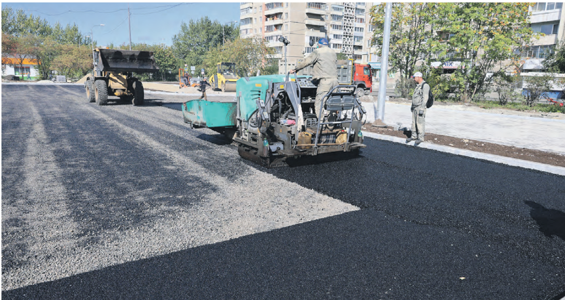
Асфальтирование парковки.
