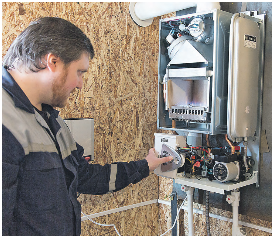
Мастер подключает газовое оборудование.
