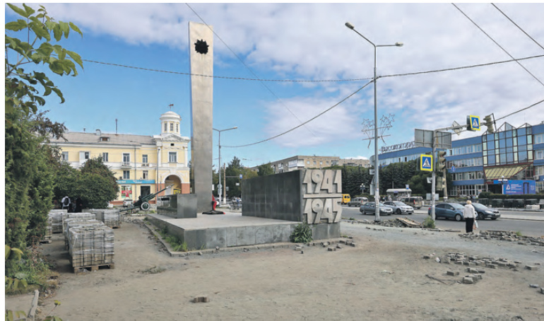
Старое покрытие демонтировали.
