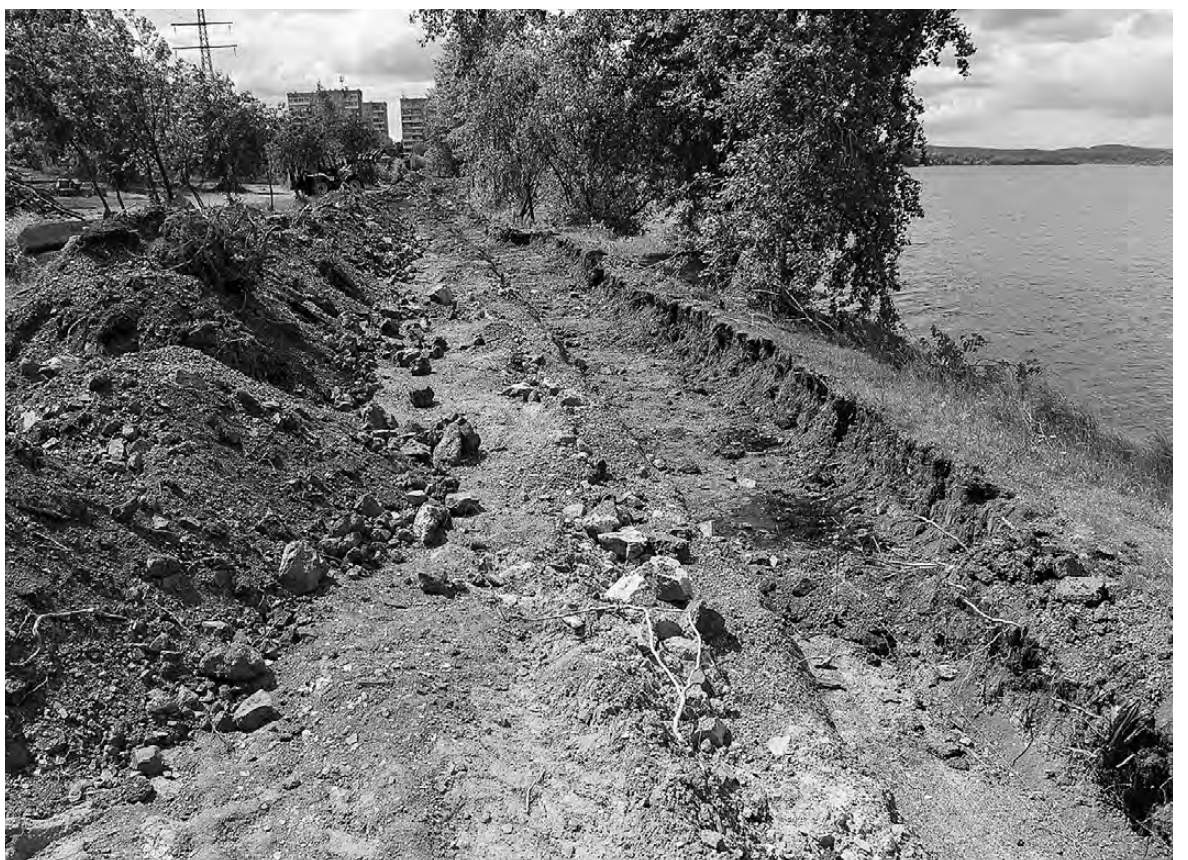
После замены труб строители приступят к полномасштабному благоустройству сквера.
