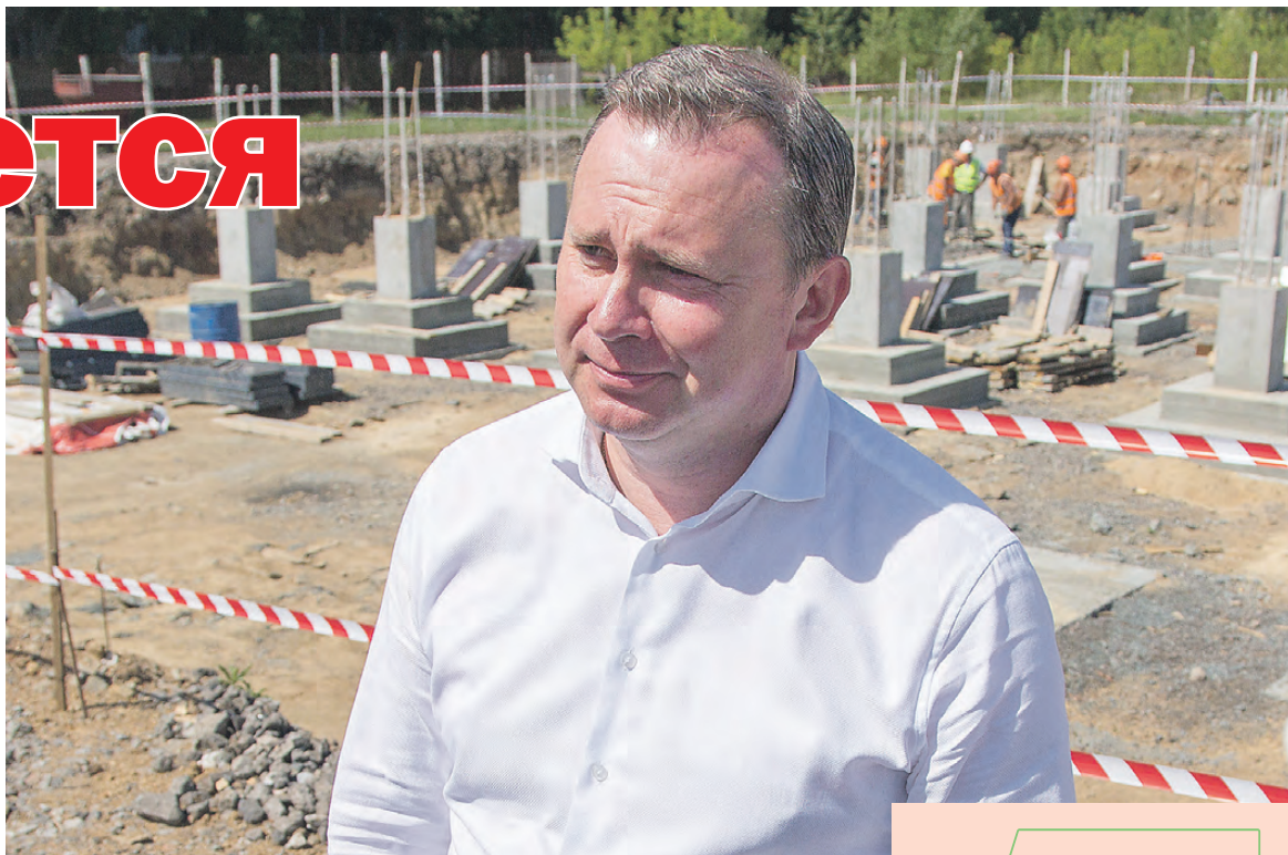
Строительная площадка культурно-образовательного центра.
