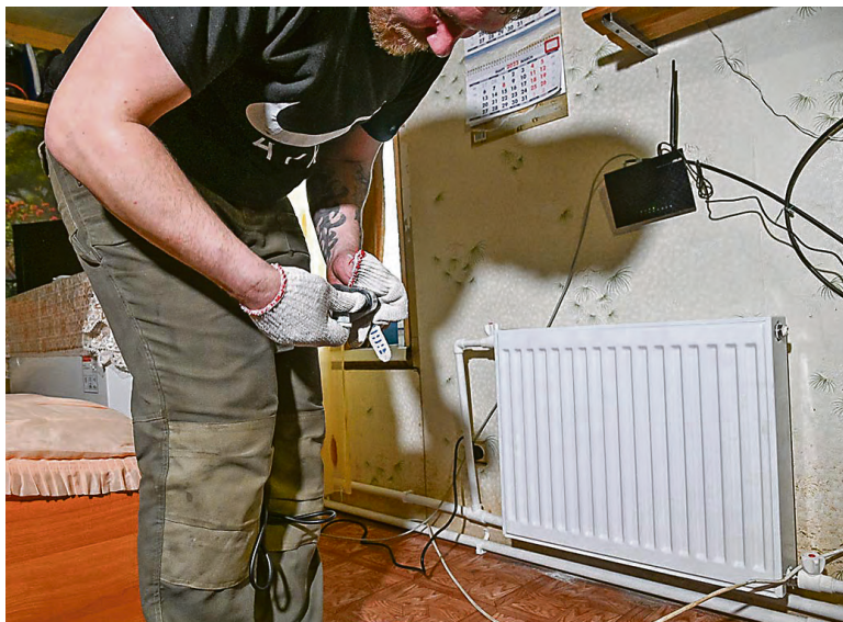
Монтаж радиаторов отопления.
