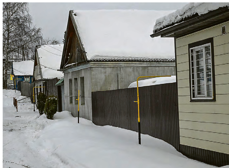
Осталось завести трубу в дом.
