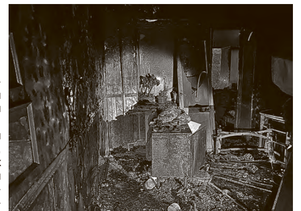
Последствия пожара в доме на пр. Дзержинского.
